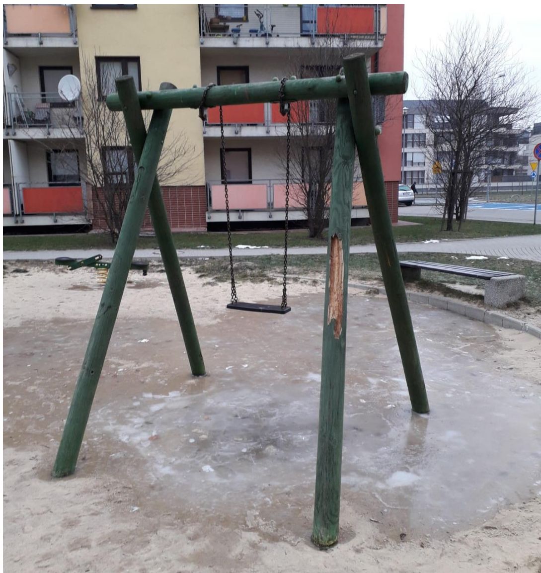
USZKODZONA BELKA HUŚTAWKI
