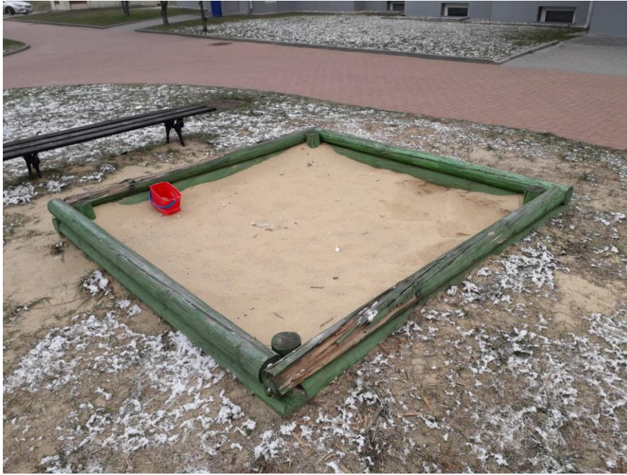
USZKODZONE BELKI DREWNIANE
