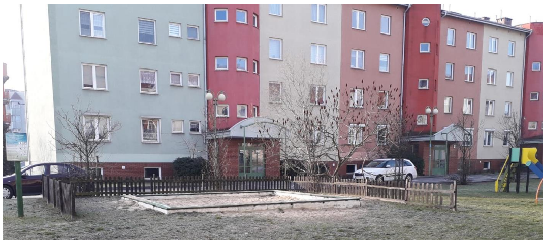
BRAKUJACE SZTACHETKI W OGRODZENIU
