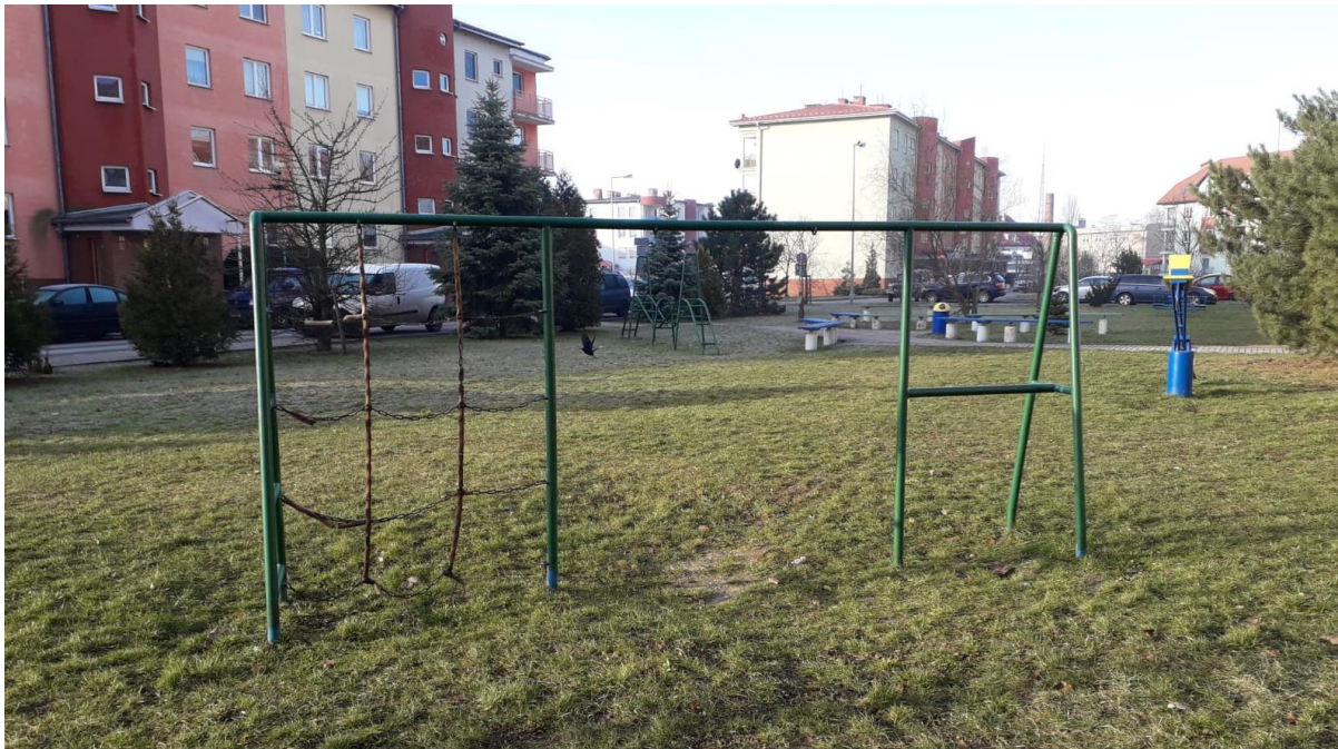
BRAK HUŚTAWKI ORAZ USZKODZONE ŁAŃCUCHY
