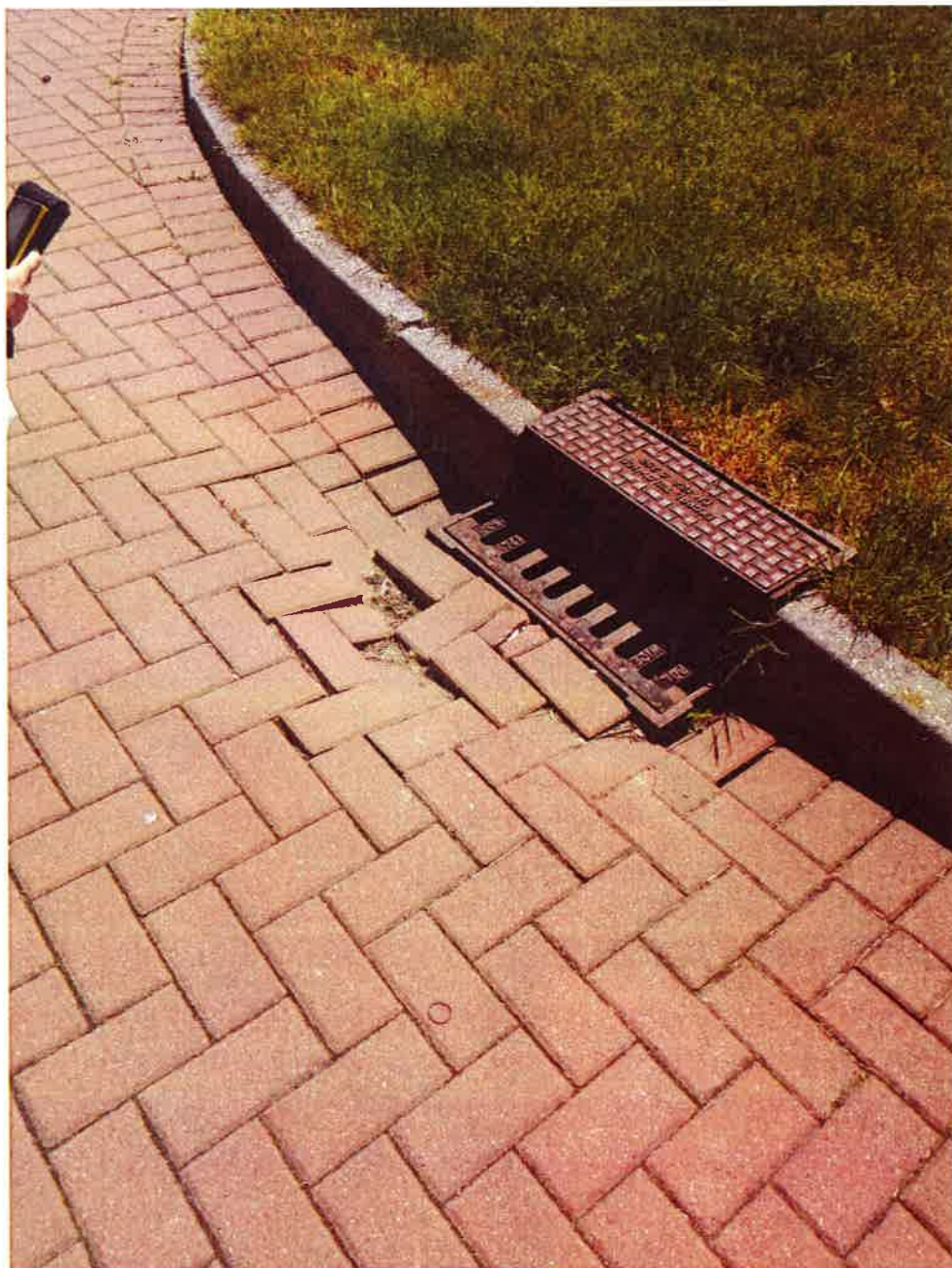
Naprawa powierzchni dokola studzienki kanalizacyjnej 2x1m
